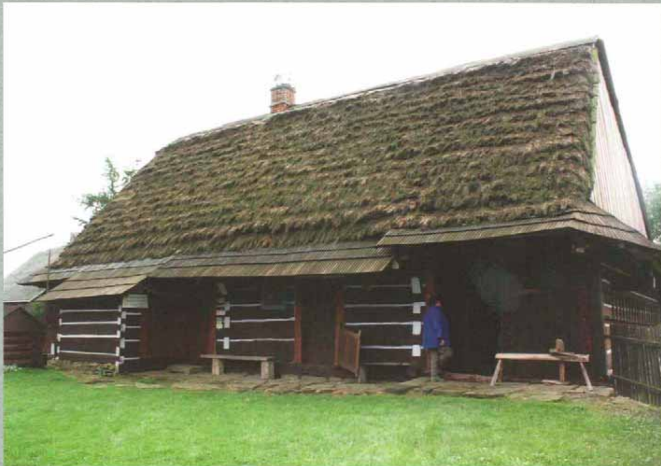
2. WIDOK BUDYNKU OD STRONY WSCHODNIEJ.
