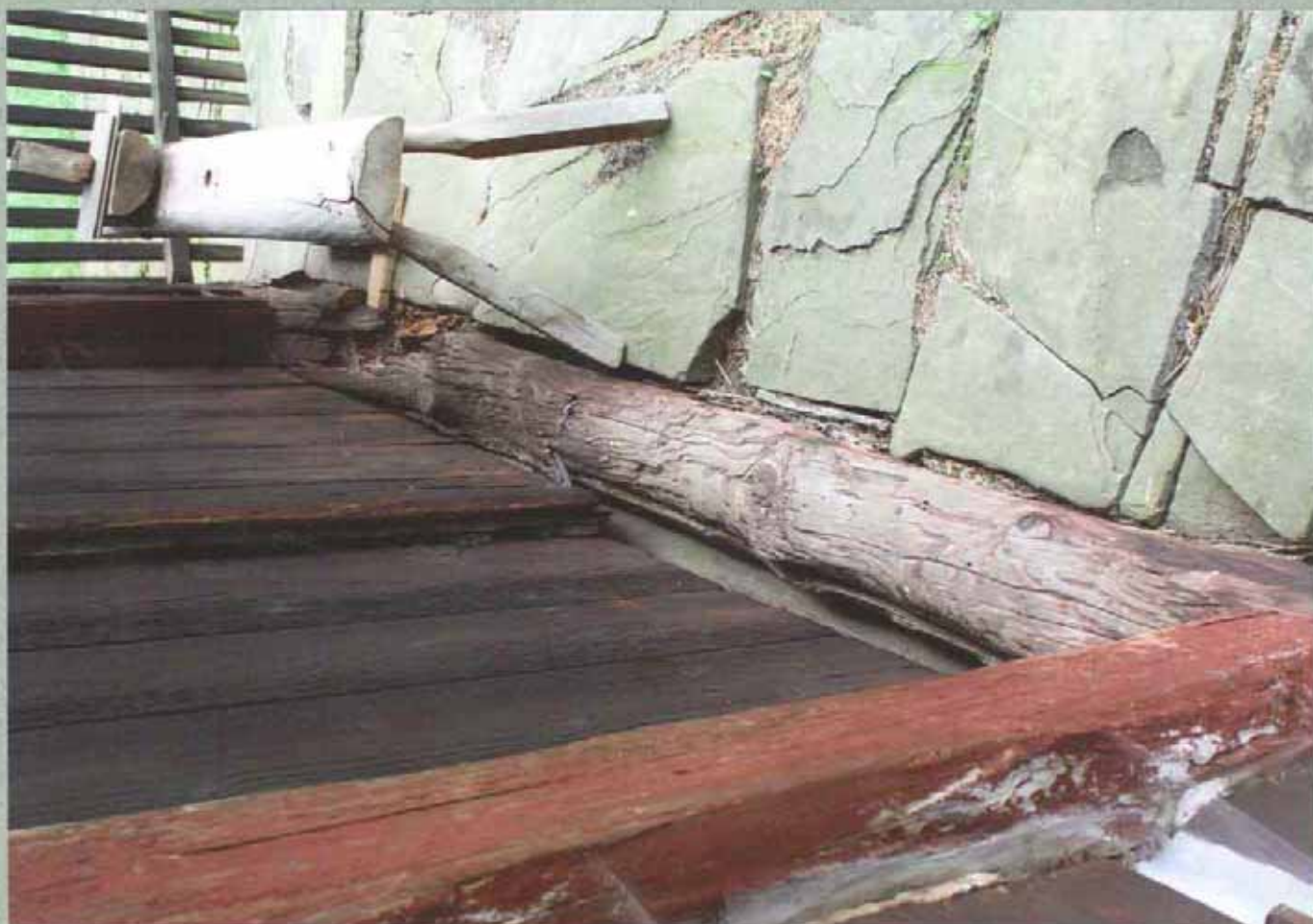
8. ZNISZCZONY I POKRUSZONY ELEMENT PODWALINY W PARTII PRUGU BOISKA.
