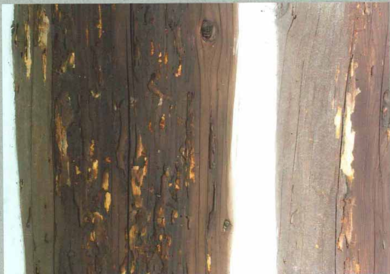
6. ZBLIŻENIE ŚWIEŻYCH OTOWRÓW WYLOTOWYCH W BELKACH ŚCIAN.
