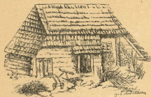
Fig. 3. Chyba na Magórze nadstrowskiej.
